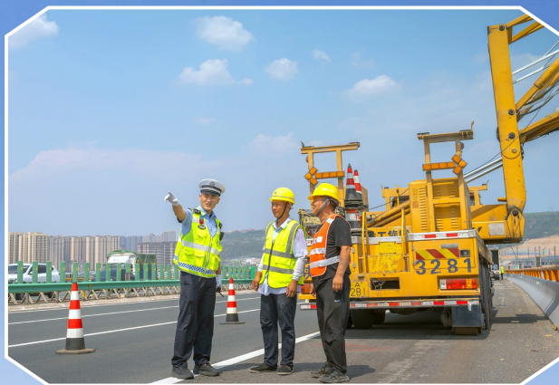
7月31日,西安市公安局交管支队高交大队西柞中队民警在指导路面施工人员优化安全防护措施。
